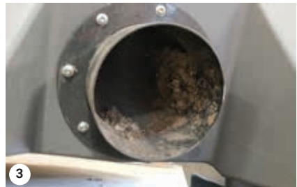
Vstup cez nádrž na vodu
