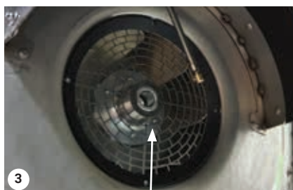
Mriežka rotačného filtra
